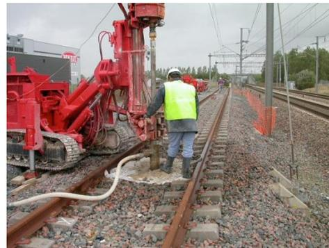
Deep-mixing com pré-furação das camadas de apoio da via (INNOTRACK, 2008)
